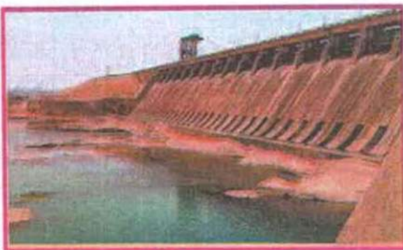
Fig.- 3.2 Hirakud Dam
